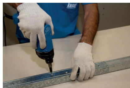
Opção 3: utilizar outro montante no lugar da guia.
