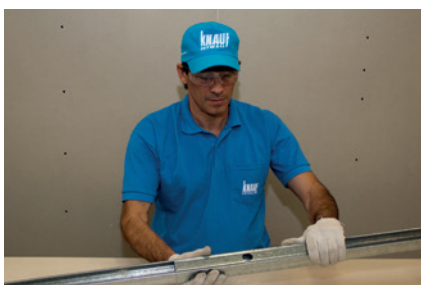
Opção 1: fazer o transpasse com uma guia e dois montantes.
